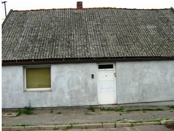
Rys. 7. Pokrycie dachowe ocenione w II stopniu pilności.
