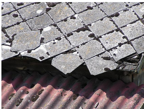
Rys. 8. Pokrycie dachowe ocenione w I stopniu pilności.
