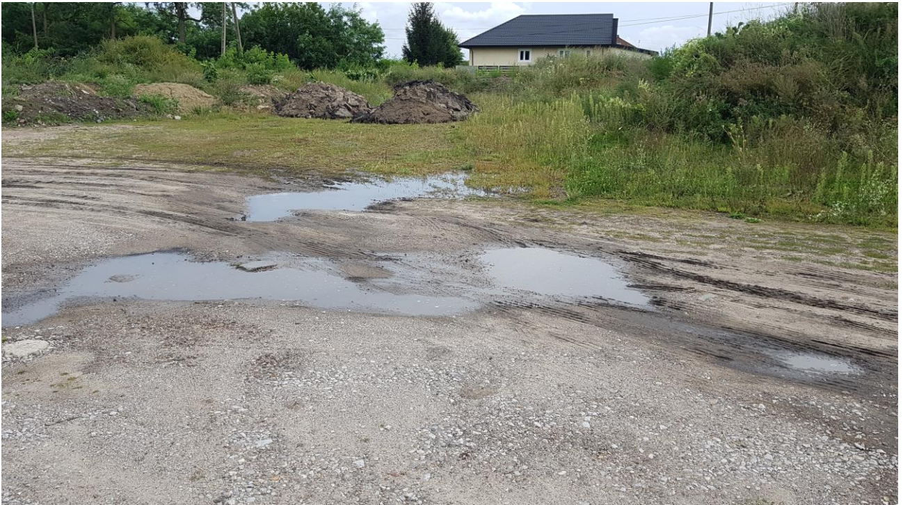
Zdjęcie Nr 11. Obszar D, wieś Mysłaków. Wgląd na teren działki Nr 404 z drogi gminnej w kierunku wschodnim.
