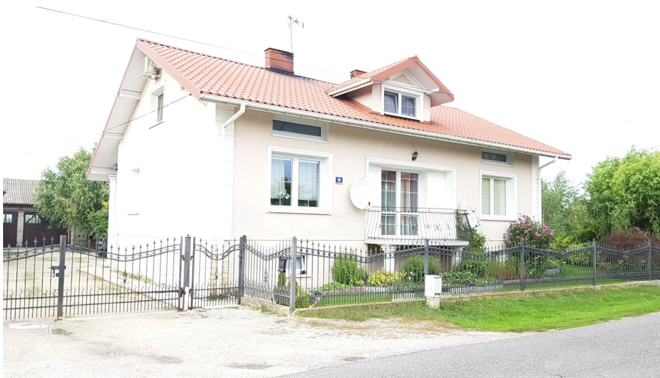
Zdjęcie Nr 2. Obszar A, wieś Bednary. Wgląd na zabudowę zagrodową z drogi powiatowej Nr 2700E w kierunku północno wschodnim.
