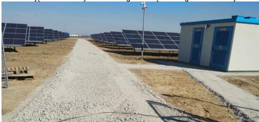
Zdjęcie 10 Przykładowa droga wewnętrzna w granicach farmy
