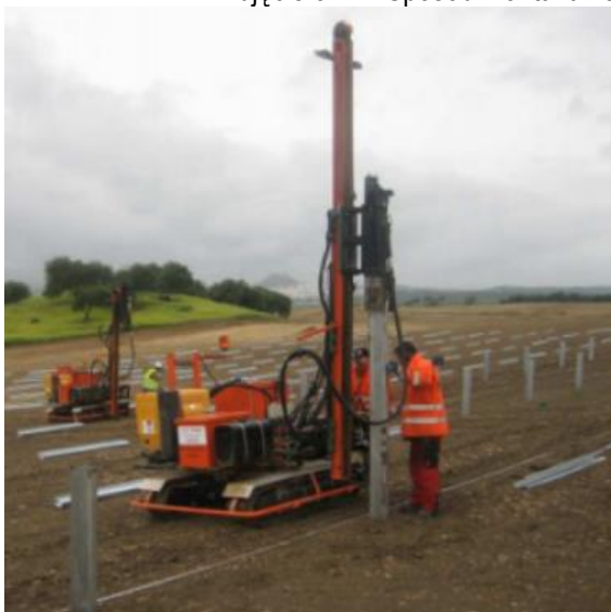
Zdjęcie 5 Sposób montażu konstrukcji fotowoltaicznych
