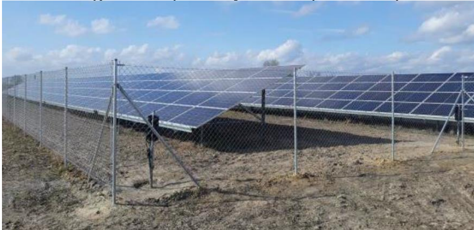
Zdjęcie 9 Przykładowe ogrodzenie farmy fotowoltaicznej
