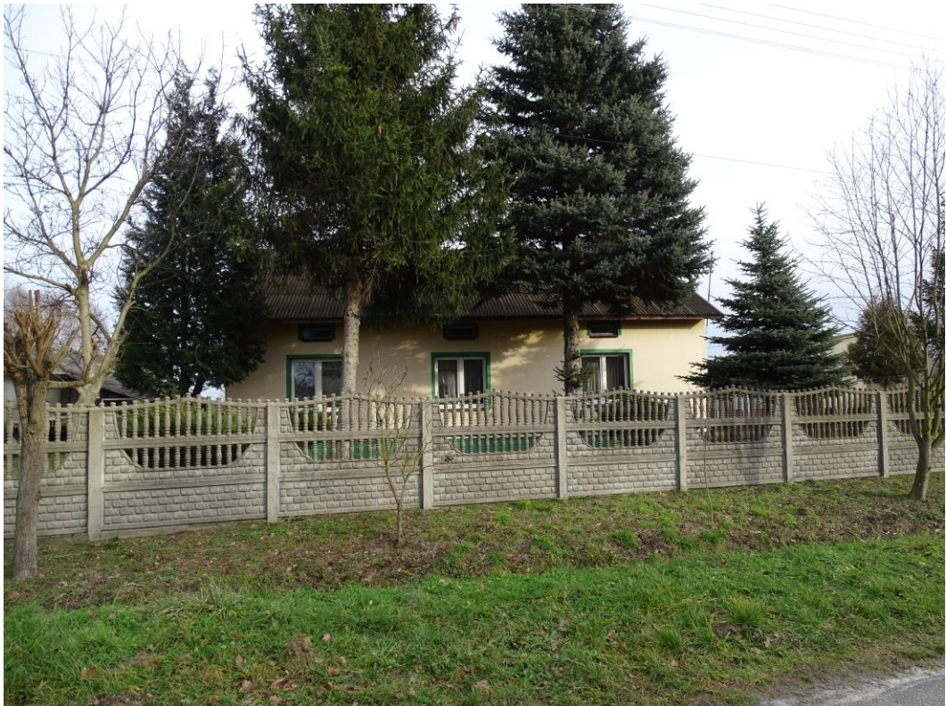
Zdjęcie Nr 2. Obszar Bobrowniki. Wgląd na zabudowę na działce ewidencyjnej Nr 499 z drogi gminnej w kierunku północno-zachodnim.
