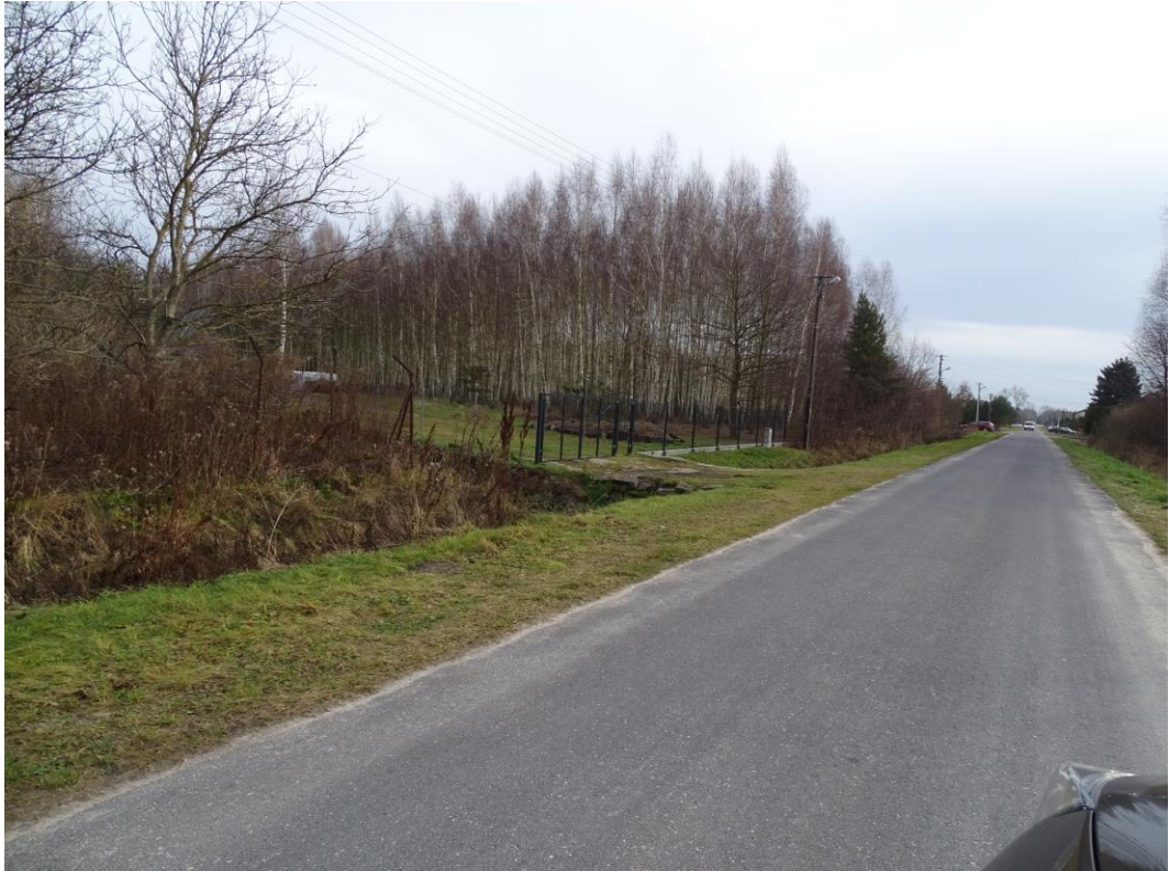
Zdjęcie Nr 9. Obszar Bobrowniki. Perspektywa drogi gminnej w kierunku południowo-wschodnim.
