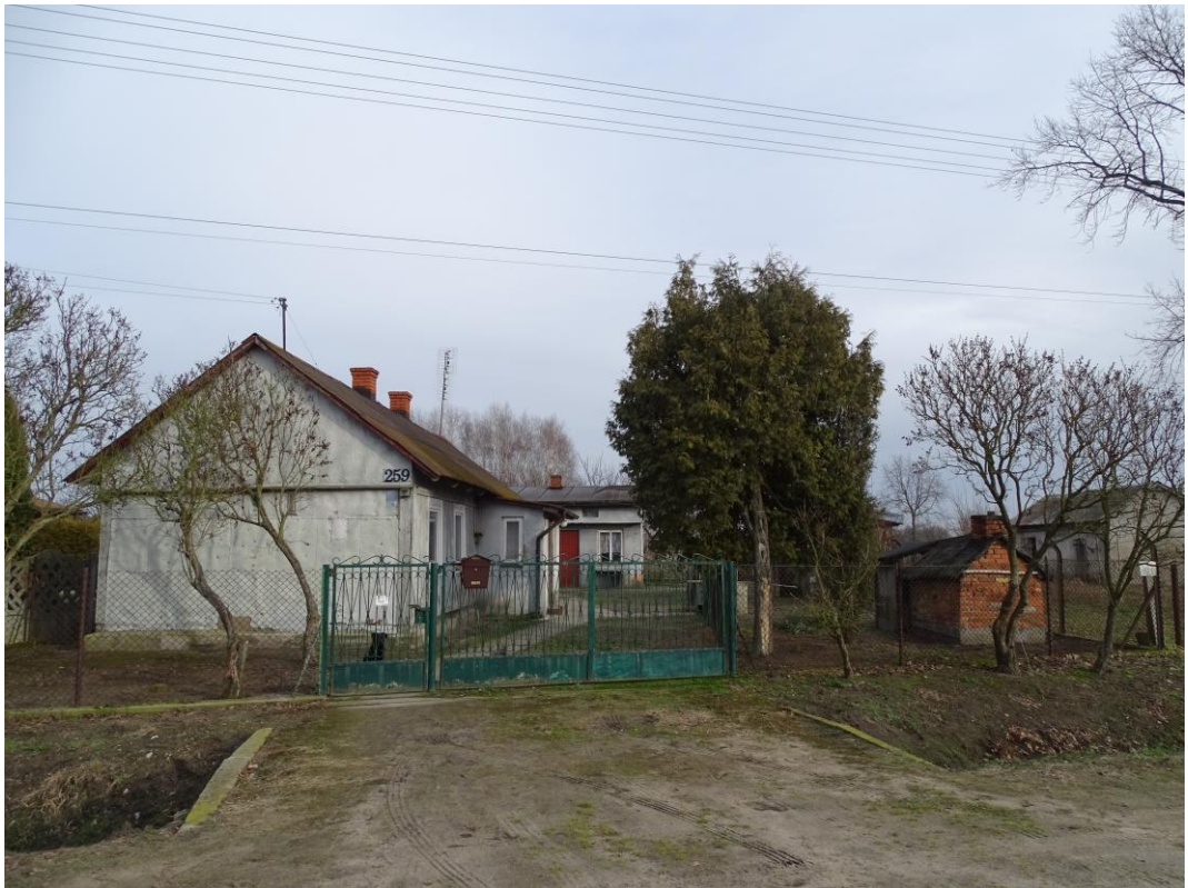
Zdjęcie Nr 3. Obszar Bobrowniki. Wgląd na zabudowę na działce ewidencyjnej Nr 519 z drogi gminnej w kierunku północno-zachodnim.
