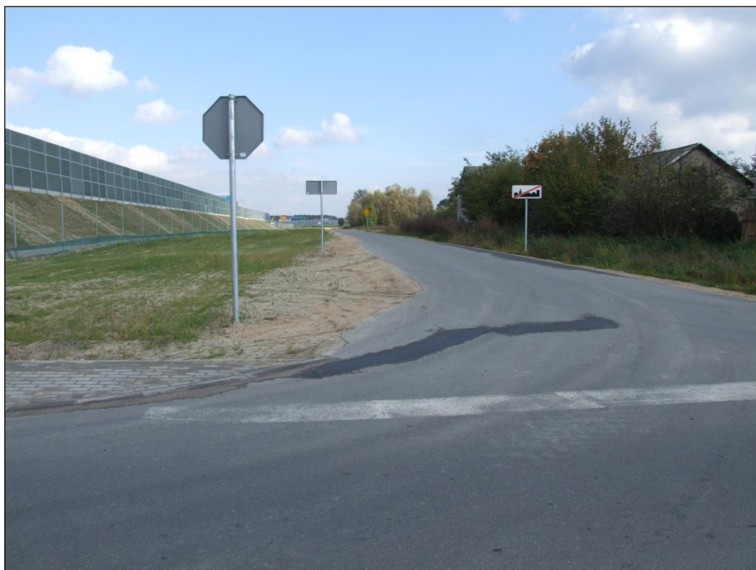
Wieś Dzierzgów. Droga dojazdowa nawiązująca do drogi wewnętrznej (działka Nr 510/2) wgląd z drogi powiatowej Nr 2704E w kierunku północno-wschodnim.
