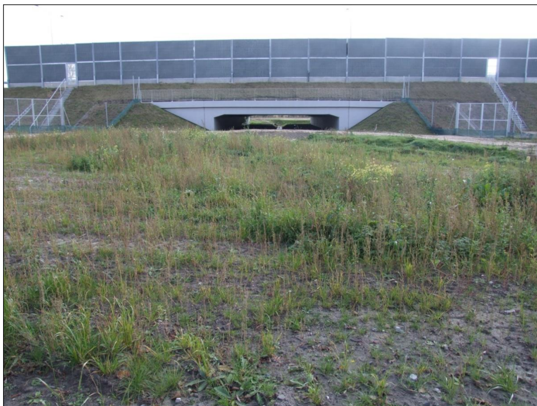
Wieś Dzierzgów. Rów z przejściem dla zwierząt pod autostradą A2.
