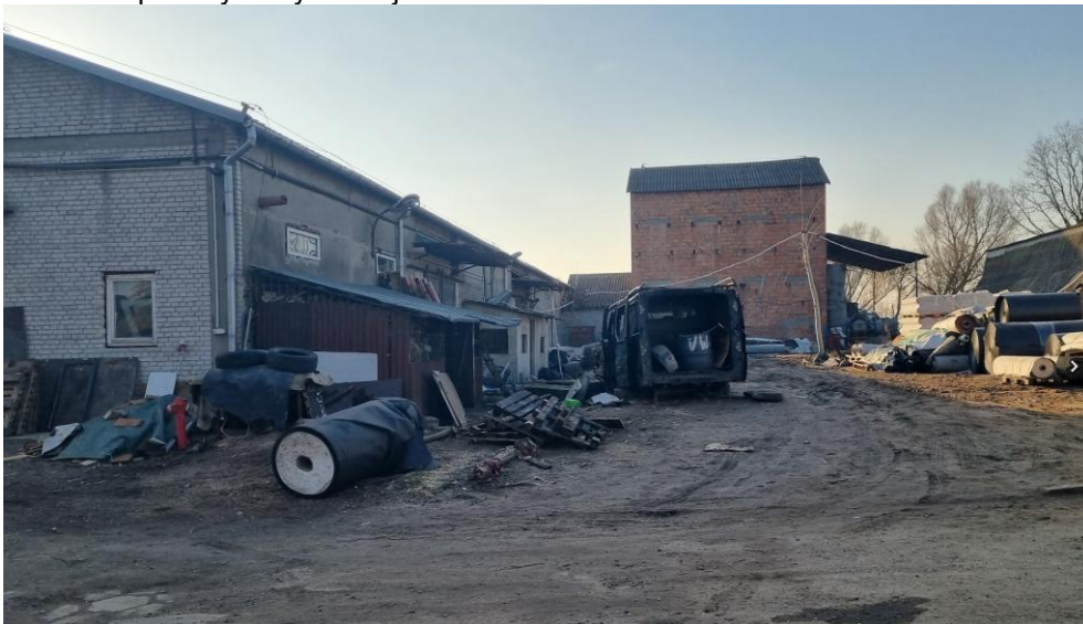
Fotografia 6. Teren przemysłowy w miejscowości Nieborów
