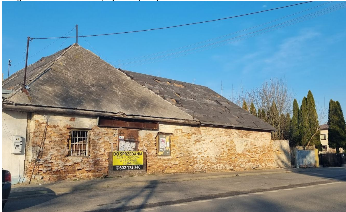
Fotografia 12. Stan obiektów przy Alei Lipowej
