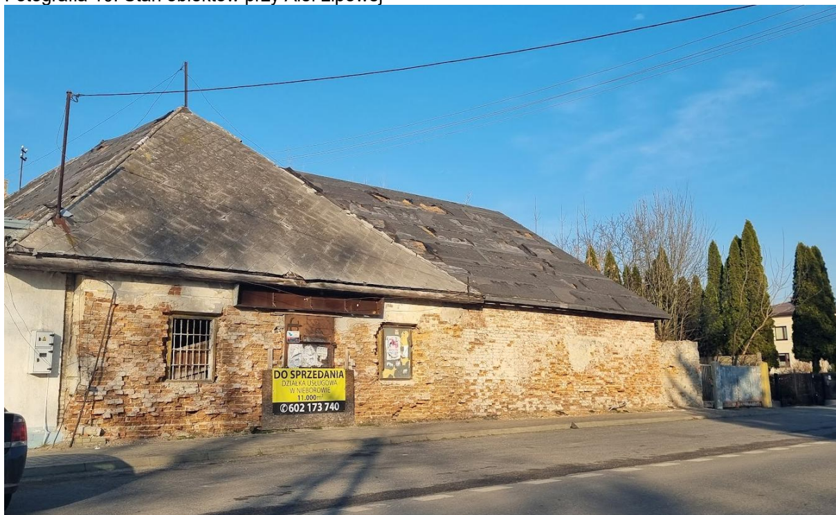
Fotografia 10. Stan obiektów przy Alei Lipowej
