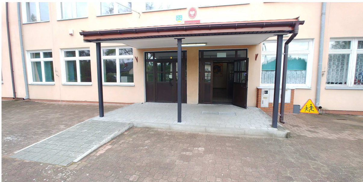
Fot. 1. Widok na wejście do budynku (elewacja południowa).
