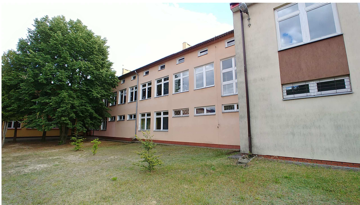
Fot. 2. Widok na elewację północną.
