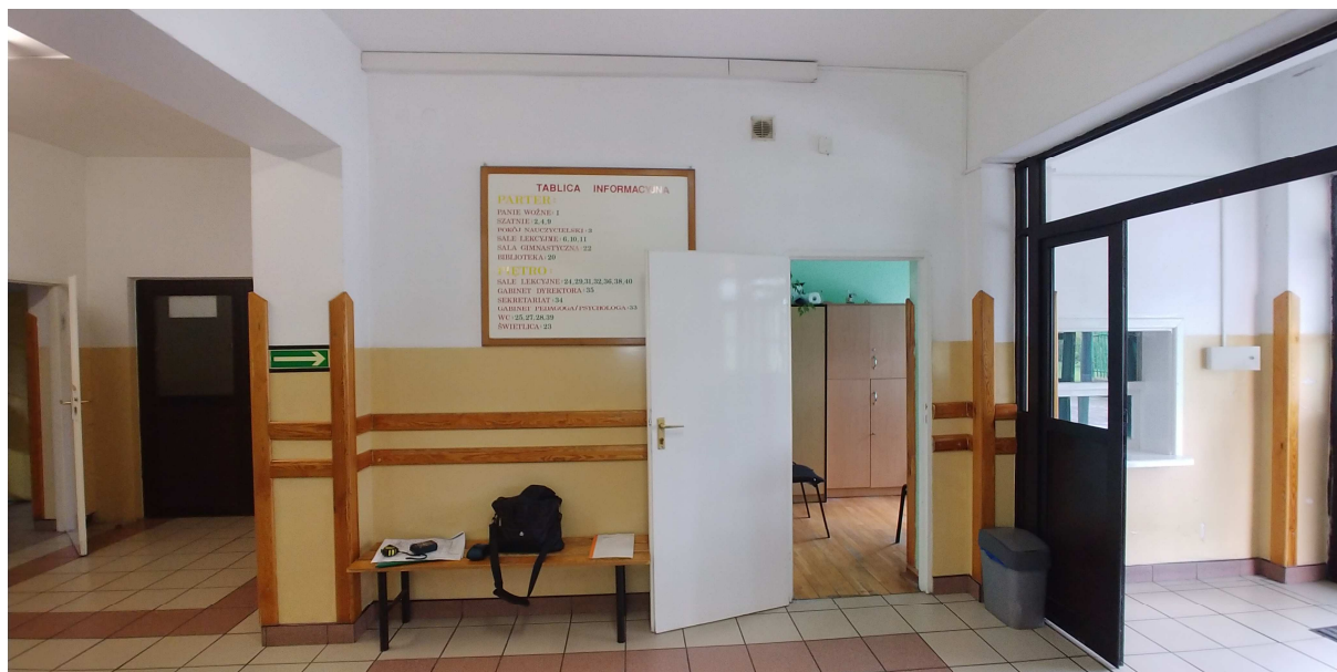
Fot. 4. Hol, widok na ścianę na której zaprojektowano przebicie dla drzwi do WC ogólnodostępnego i niepełnosprawnych. Po prawej widok na drzwi do projektowanej wózkowni (po prawej) oraz drzwi do wiatrołapu, przeznaczone do wymiany na nowe.
